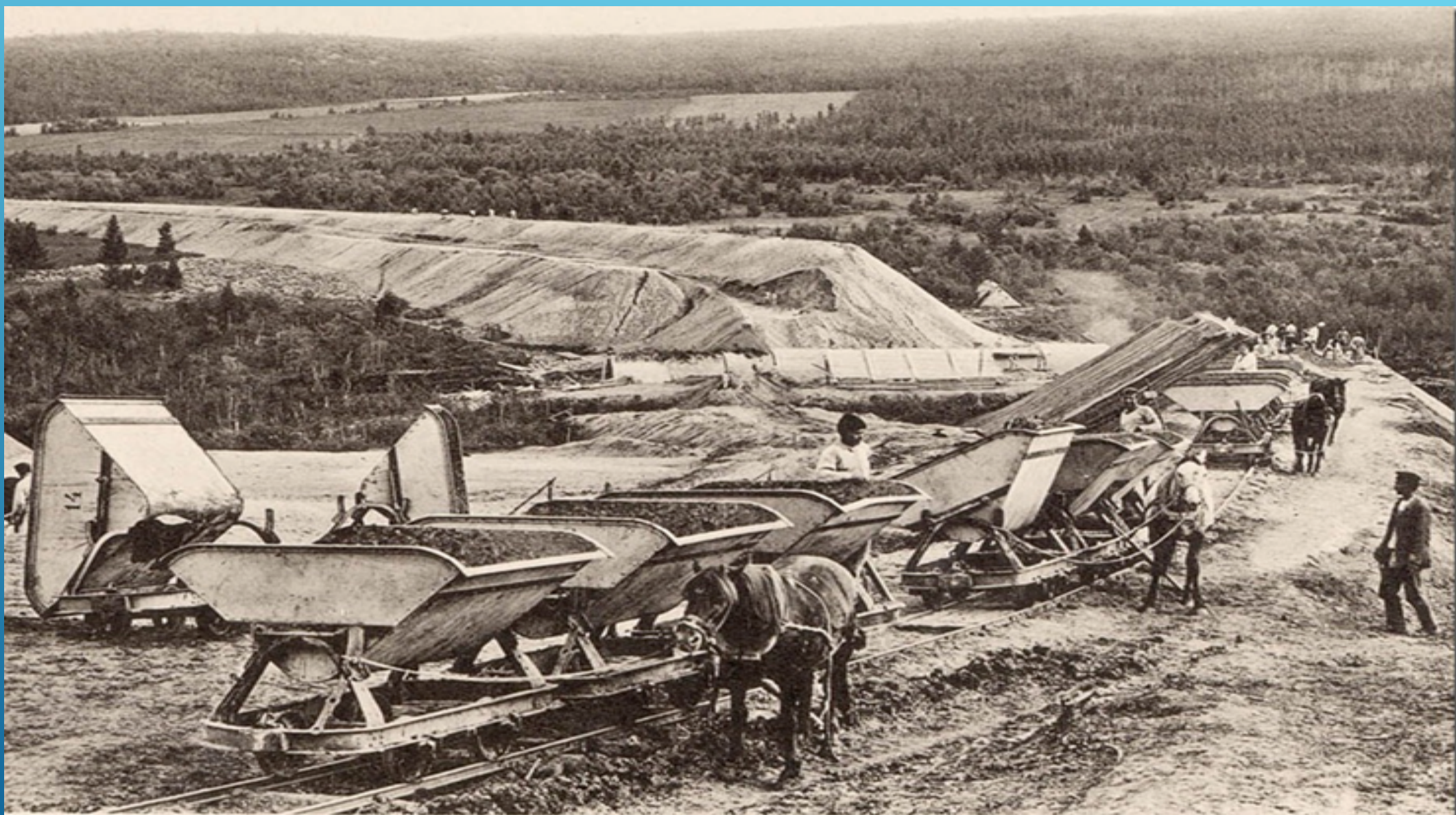
2030 ВЕРСТА. СООРУЖЕНИЕ НАСЫПИ.
