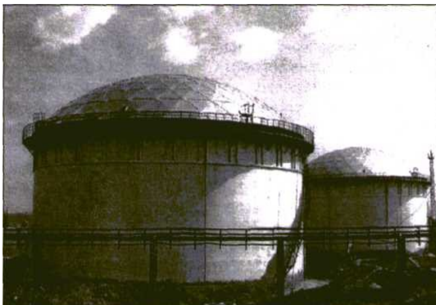
Рис. 8. Резервуары с купольной сварной алюминиевой крышей
