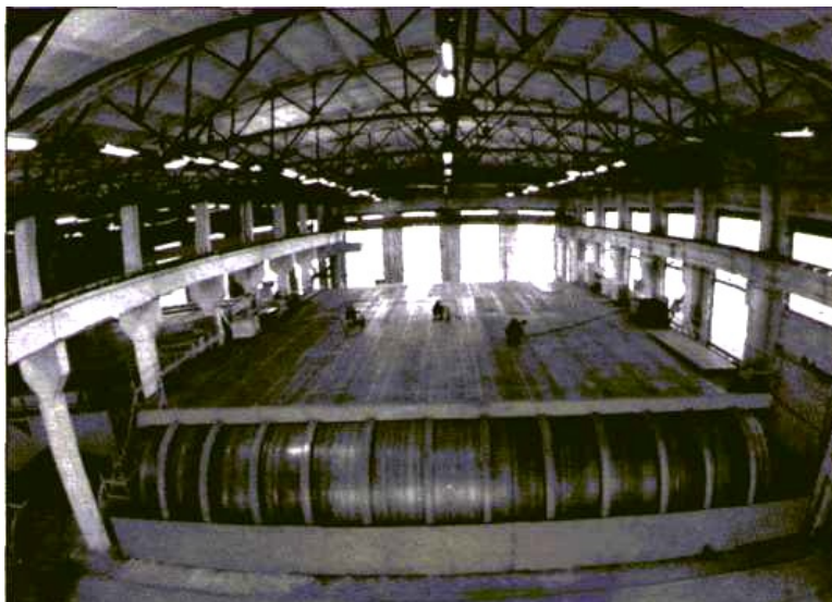
Рис. 9. Автоматическая сварка под флюсом стенки рулонизируемого резервуара
