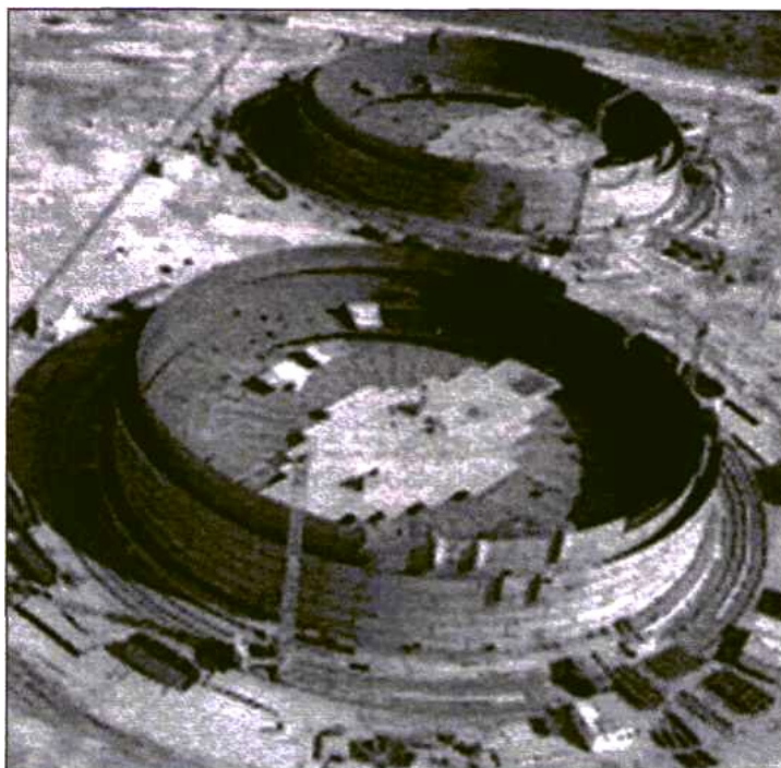
Рис. 11. Монтаж парка резервуаров по 125000 м 3 с двойными стенкой и дном (Чехия)
